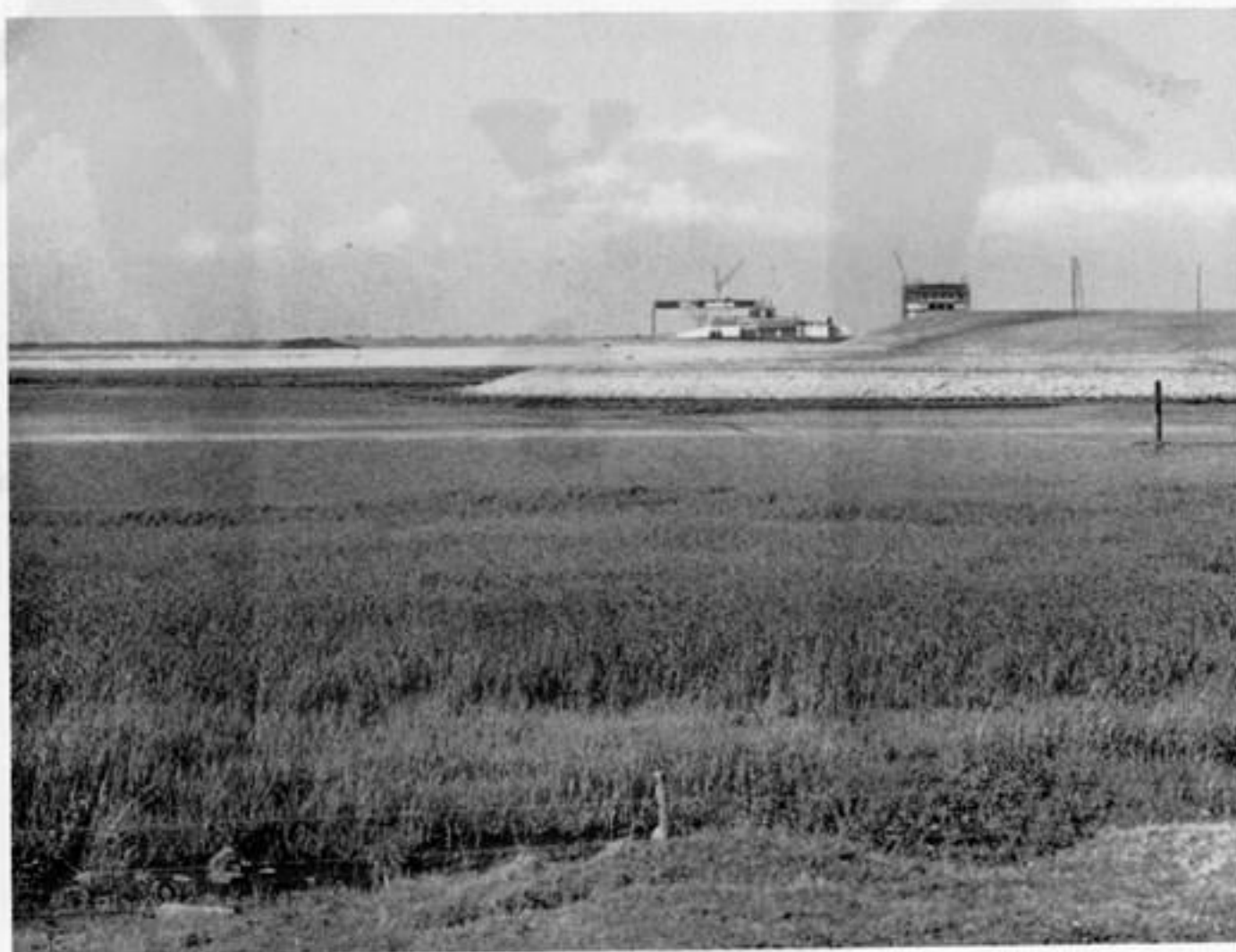
de verbinding met Voorne Putten bij Stellendam in aanbouw
