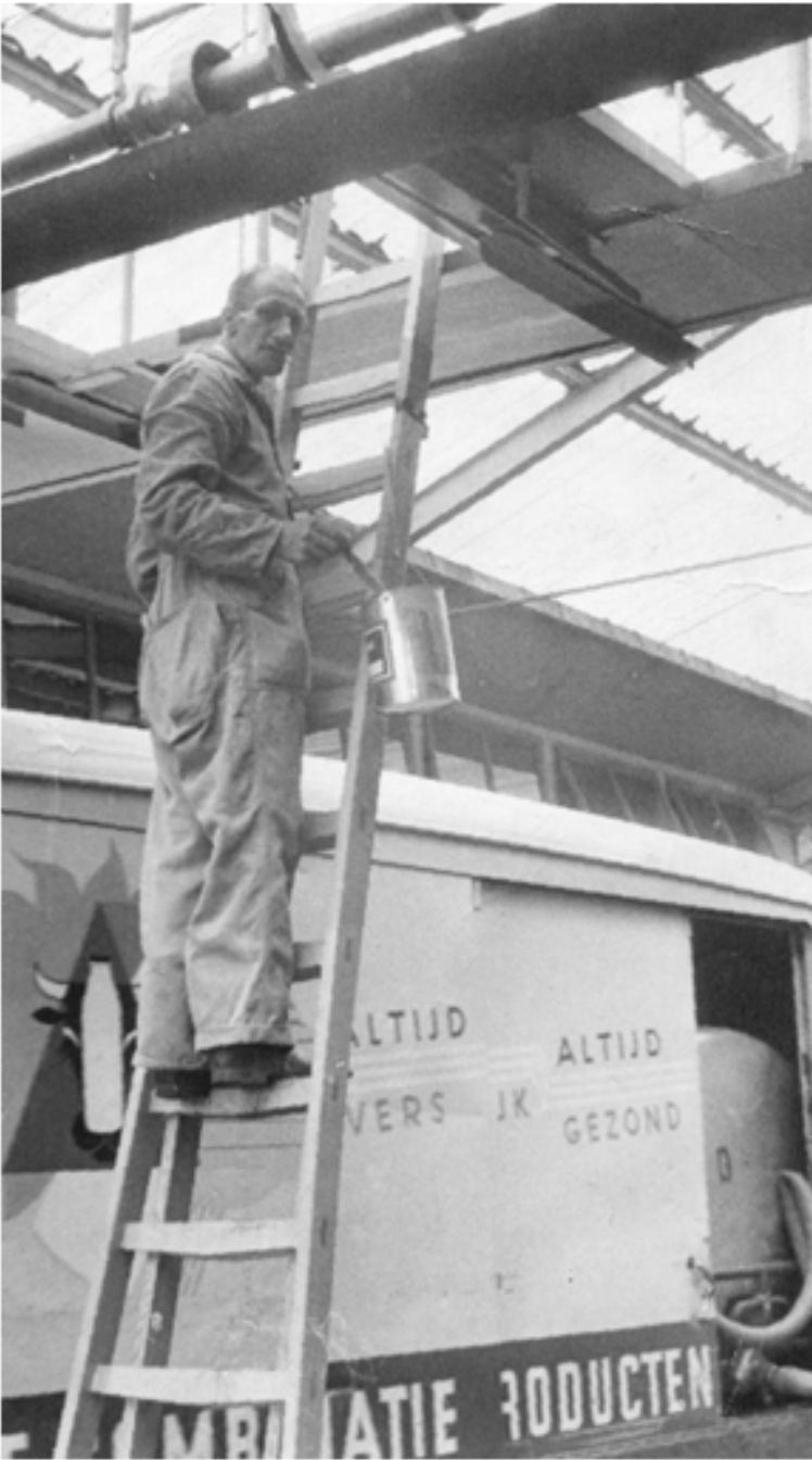
Marinus Boer met verfpot en kwast tussen de spanten van de dankoverkapping van zuiverfabriek De Combinatie. Foto P. Logmans-Boer
